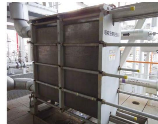
CO<sub>2</sub>回収プロセスで使われるアミン溶液の熱回収(ガasket型PHE)
