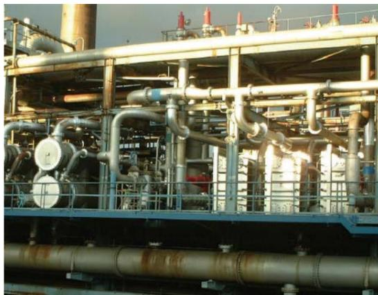
石油化学プラントのクエンチウォーターの冷却
