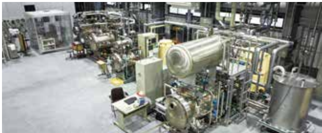
食品・医薬開発試験室 試行錯誤を重ねながら、お客様のニーズを具現化できる新装置や新システムを開発します。持込試験にも対応可能な、レトルト食品の基礎となる調理殺菌レシピの開発拠点です。
