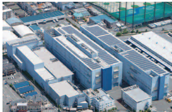
鴻池事業所 全景 総延べ床面積 56,464m 2
