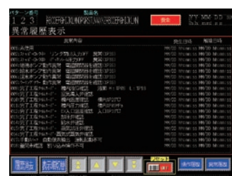
制御盤の表示例
