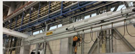
天井クレーンを廃止し小回りの利く小型クレーンを設置
