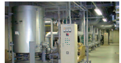
↑D社I発電所
