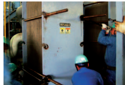
オンサイトメンテナンス 熟練したメンテナンスパートナーによる出張サービスです。「プレート式」のガスケット交換、再組み立てなどを実施される場合、お電話1本でサービスエンジニアが現地にお伺いし、メンテナンス作業を強力サポートします。
