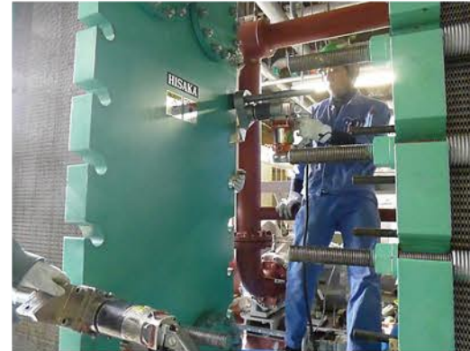
現地メンテナンスサービス 自動締付機を使って短時間での組立が可能です。
