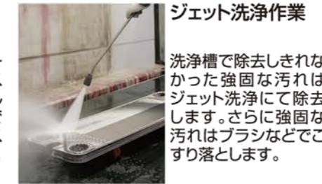
ジェット洗浄作業
